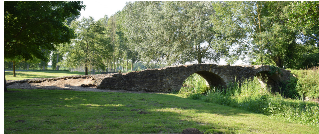
Figure 9 : Pont de la Reine Blanche, dans la vallée de la Dive
